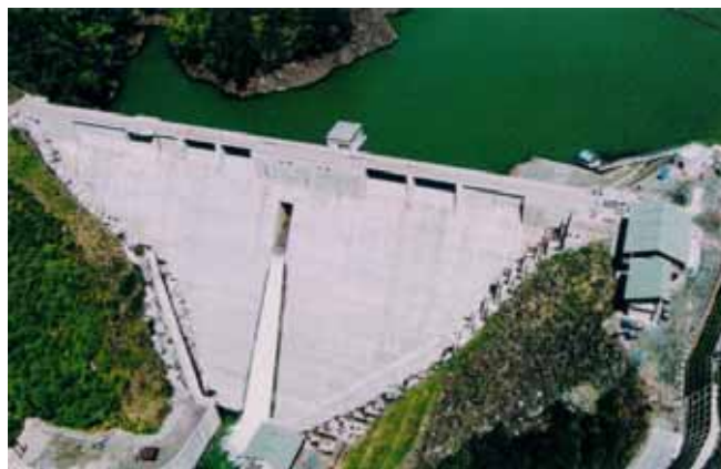
図1 姉川ダム(「月間ダム日本」2002年10月号より)
